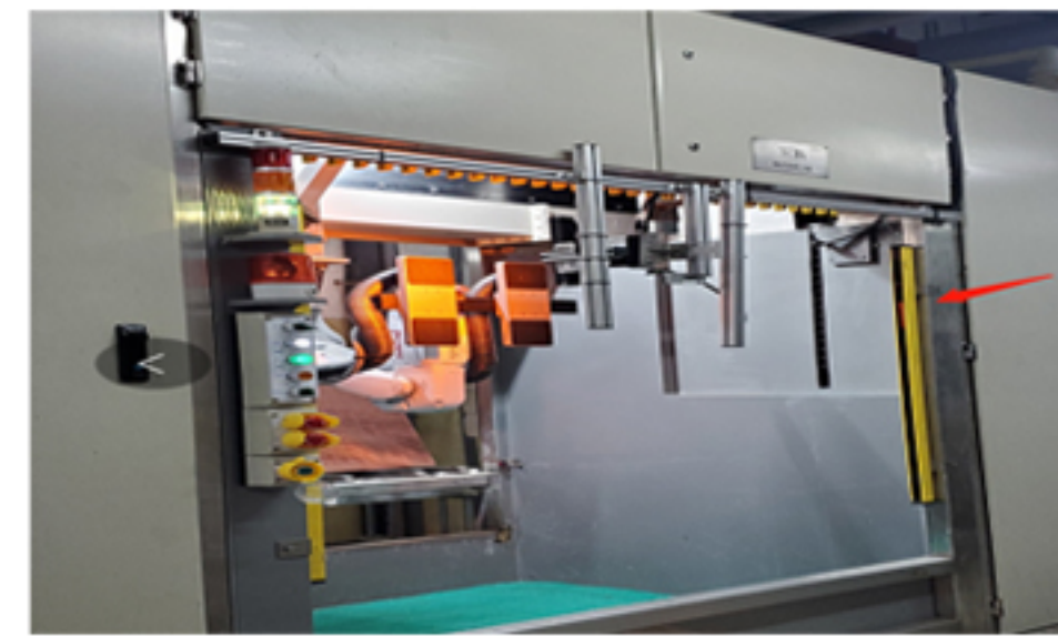
电镀VCP线配备自动的光感应装置，有效防止设备异常造成员工伤害
