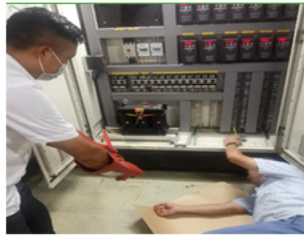
触电事故现场处理演练
