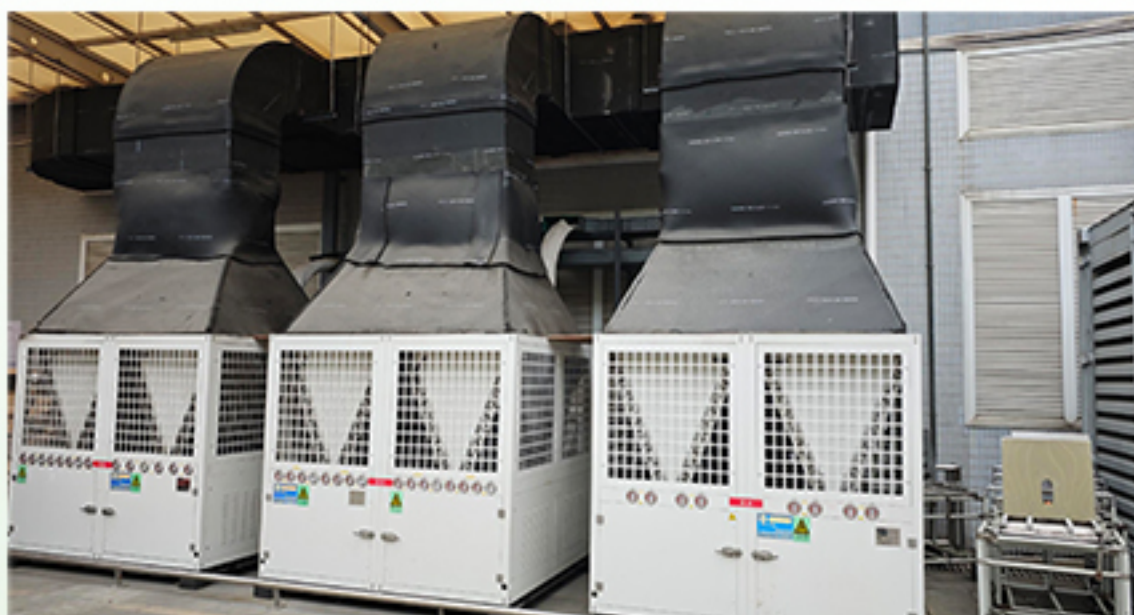
深圳崇达龙门沉铜线配套的高温槽热泵改造项目
