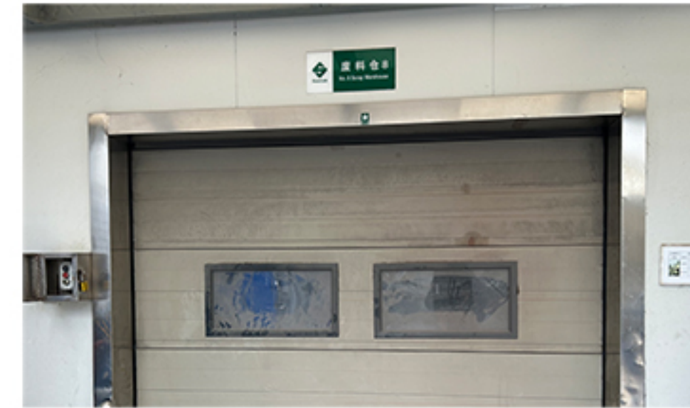
一般废料收集贮存设施
