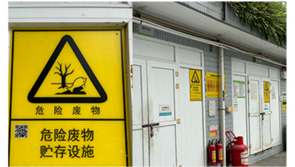
危险危废收集贮存设施
